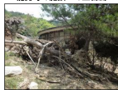
能勢町の施設への土石流
