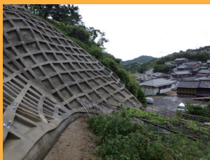
急傾斜地の崩壊対策（法面の保護）
