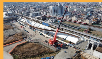
恩智川（法善寺）の「多目的遊水地」 施工状況
