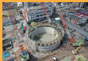
寝屋川北部の地下河川「城北立坑」 施工状況
